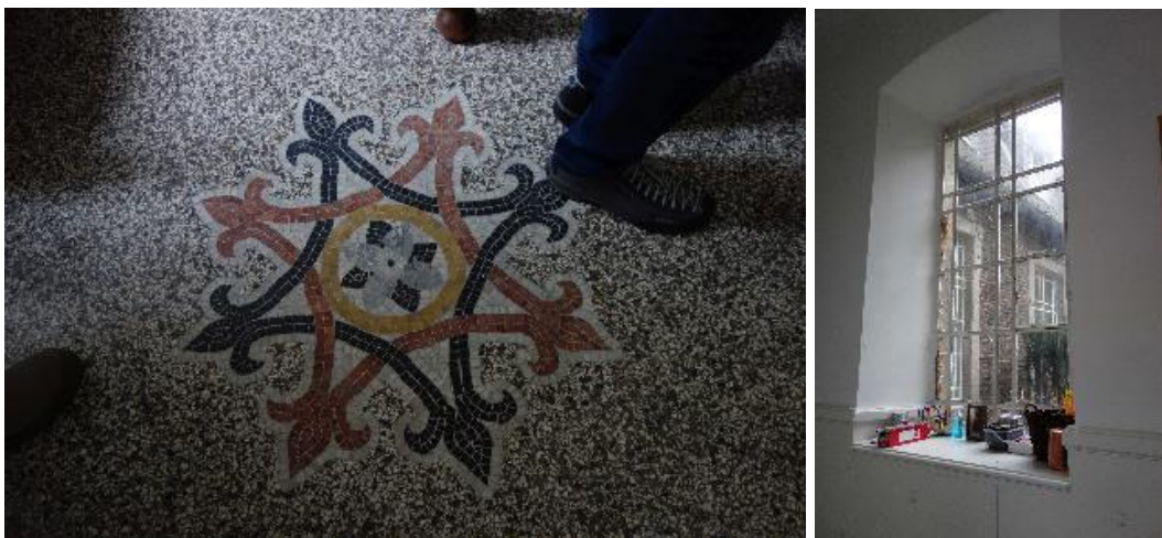
Links: Detail Schmuckfußboden aus Terrazzo; rechts: Eisensprossenfenster.
