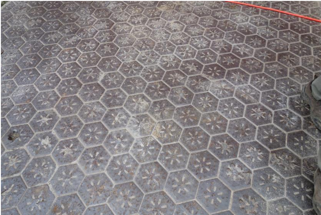
Jüchen, Wirtschaftshof des Nikolausklosters, ehem. Pferdestall, gusseiserne Bodenfliesen, Foto: NF, LVR-ADR, 2022.
