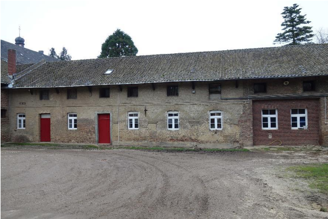
Jüchen, Wirtschaftshof des Nikolausklosters, südliche Traufseite des ehem. Schweinestalls, Foto: NF, LVR-ADR, 2022.
