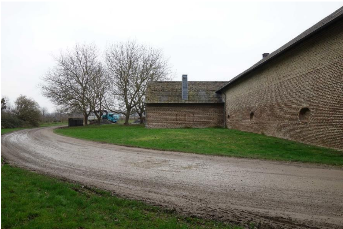
Jüchen, Wirtschaftshof des Nikolausklosters, Scheune, südliche Traufseite, Foto: NF, LVR-ADR, 2022.
